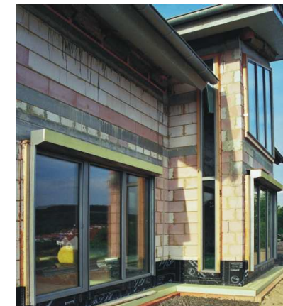
Montage Fenster mit Sonnenschutz im Rohbau
