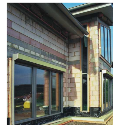
Montage Fenster mit Sonnenschutz im Rohbau
