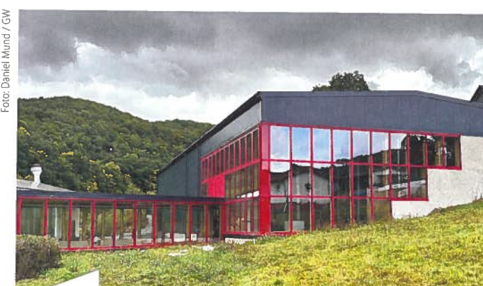
Neue Lackierhalle: Fortschrittliche Anlage sorgt für höchste Effizienz und Qualität.
